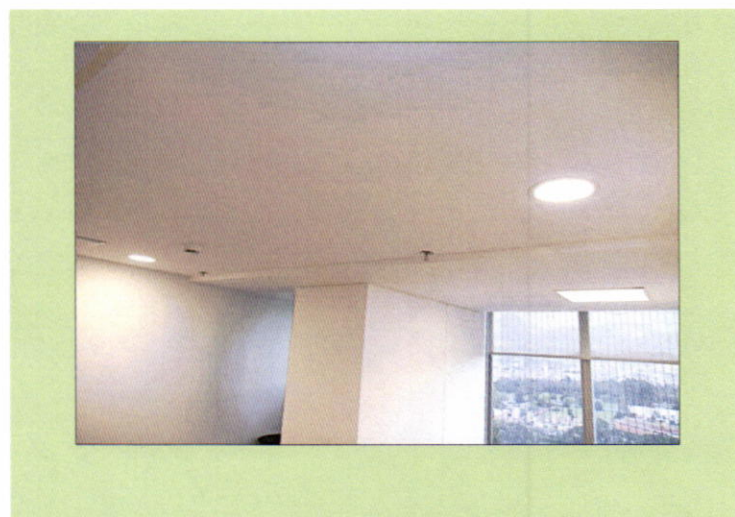
Fotografía No. 010 – Cielos rasos CENTRO EMPRESARIAL ELEMENTO.
