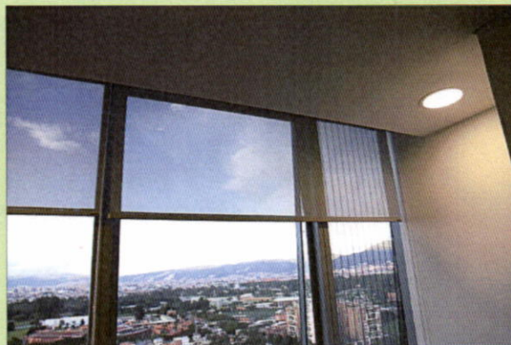
Fotografía No. 016 – Estado estructuras CENTRO EMPRESARIAL ELEMENTO.
