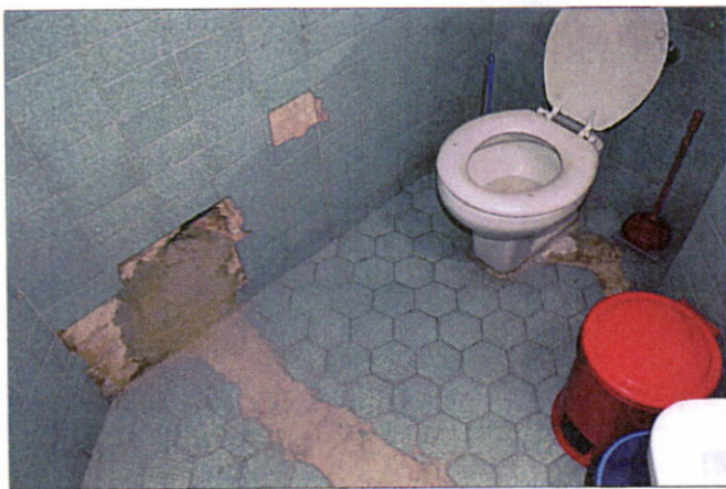
Fotografía No. 001 – Baños residencias Tequendama.
