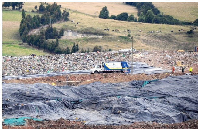
Relleno Sanitario Doña Juana Fuente: Nuevo siglo.com.co
