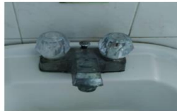
Cambio grifería lavamanos-Antes
