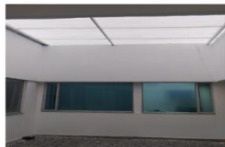
Cubierta nueva interior administrativo
