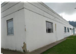
Reparación de Fachada
