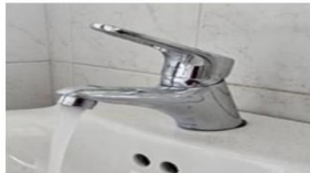
Cambio grifería lavamanos-Después
