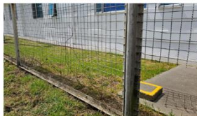
Mantenimiento malla- Antes
