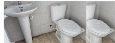
Cambio sanitarios y lavamanos
