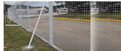
Mantenimiento malla- Después
