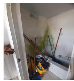
CUARTO DE ASEO
