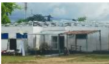
Desarrollo de trabajos en el ESM
