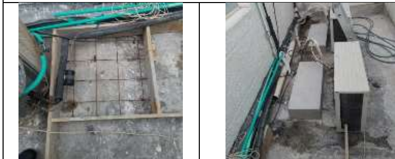
Fabricación molde de cemento para las medias cañas
