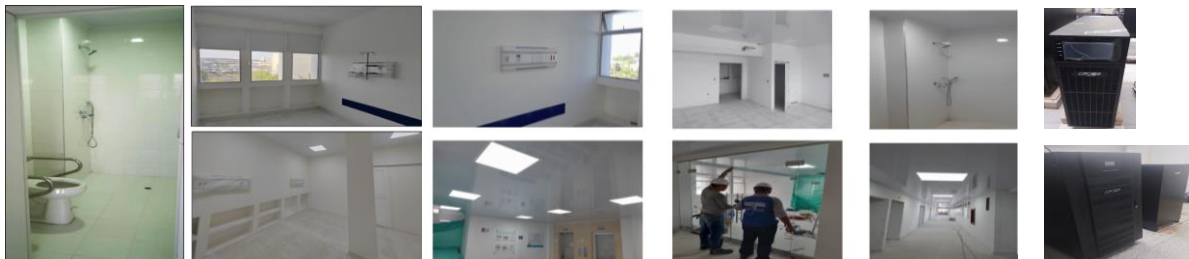
Ilustración 86. Infraestructura Área de Hospitalización
